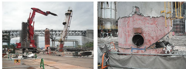
図3 押倒し風景及び先行切断状況
