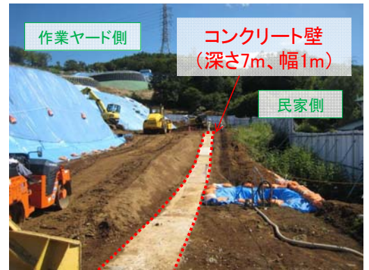
写真1 コンクリート壁の設置状況
