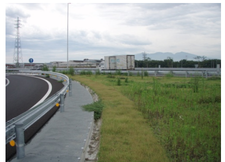
写真-1 張芝による施工状況
