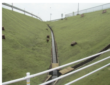
写真-2 施工直後の状況
