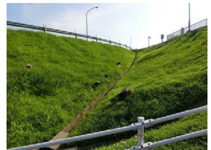
写真-3 施工1か月後の状況
