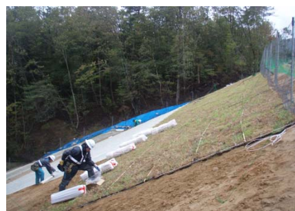
写真-8 試験施工状況
