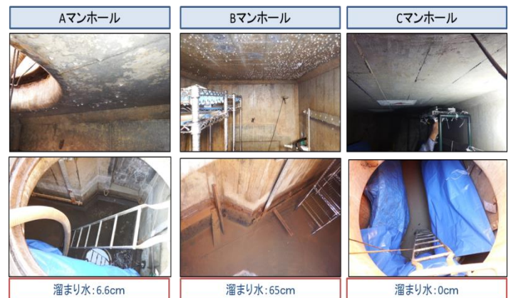
図 4 マンホール内の様子 (2015 年 2 月)
