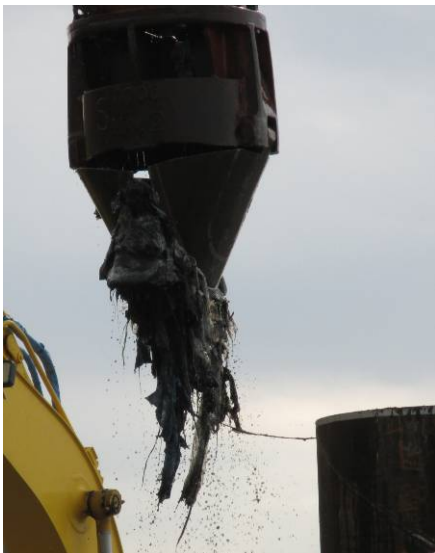
写真-1 ハンマグラブによる廃棄物の排出
