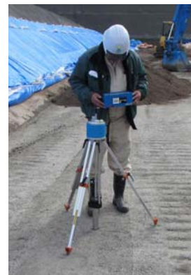
写真-2 簡易支持力測定
