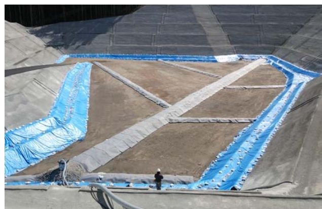
写真-5 処分場全景
