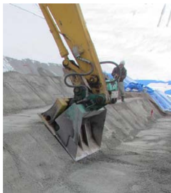
写真-1 NB 法面転圧状況
