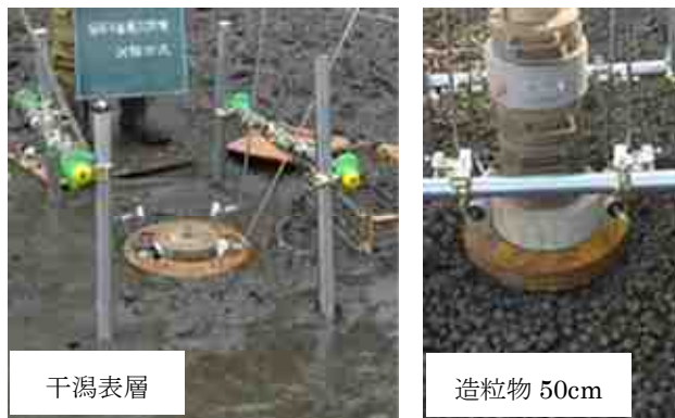
写真-1 造粒物の平板載荷試験状況
