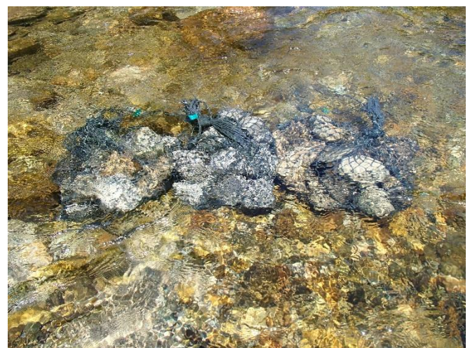
図-2 根固め用袋材設置状況
