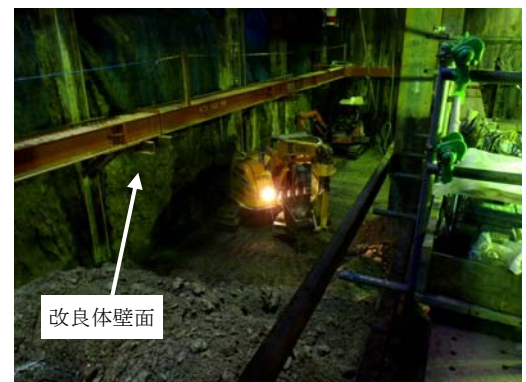
写真-3 掘削状況
