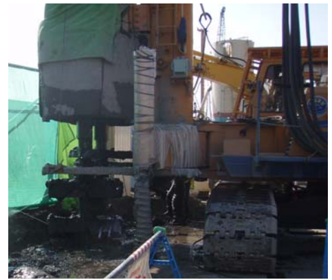
写真-1 地盤改良施工状況
