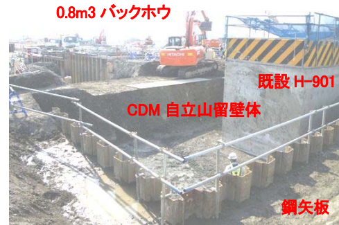
写真-3 掘削施工状況
