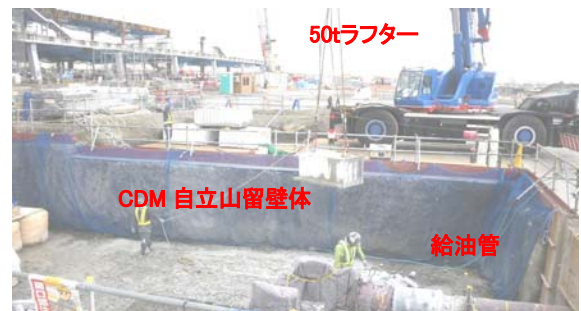
写真-4 既設H-901 解体時
