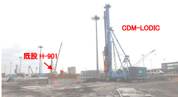
写真-2 CDM-LODIC 施工状況
