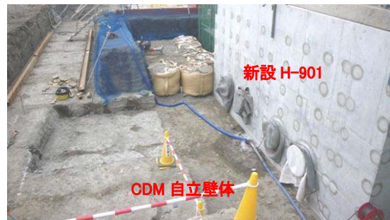
写真-5 給油管敷設前(CDM掘削時)
