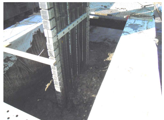
写真-1 掘削・攪拌状況
