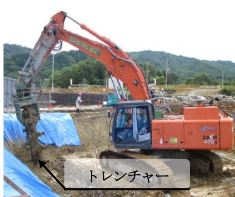
写真-1 地盤改良土留め造成状況
