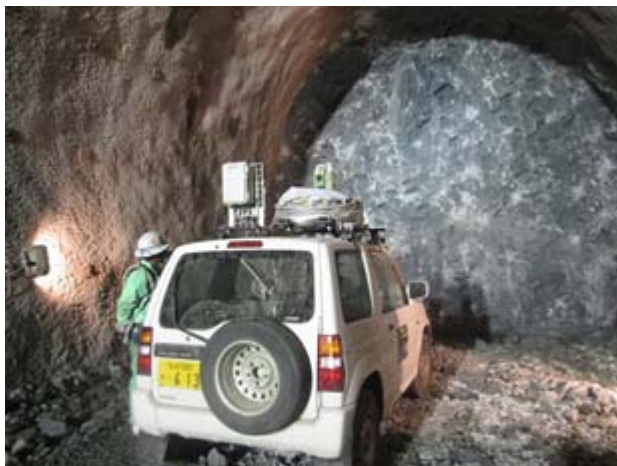
写真-1 測定状況
