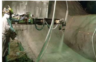
写真-2 一次インバート工施工状況
