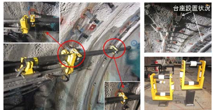
写真－3 坑内用に改良した特殊鋼管受け治具と使用状況
