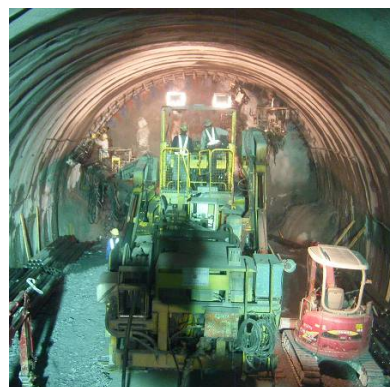
写真-1 坑内からの実施状況
