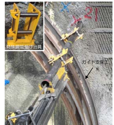
写真－2 特殊鋼管受け治具（従来型）
