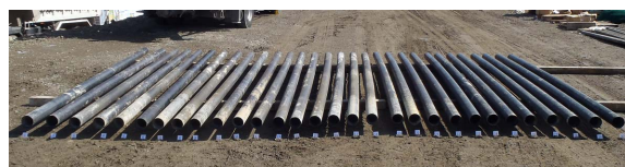
写真-2 使用後の末端管（4回転用後）
