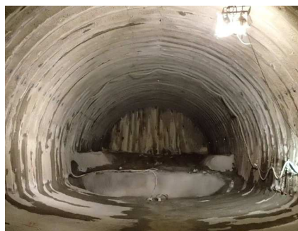
写真-1 早期閉合状況
