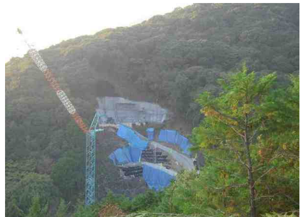
写真-1：終点側施工状況
