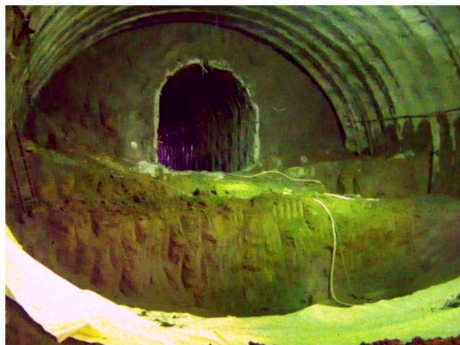
写真-1 早期閉合状況(吹付け養生シート敷設済み)
