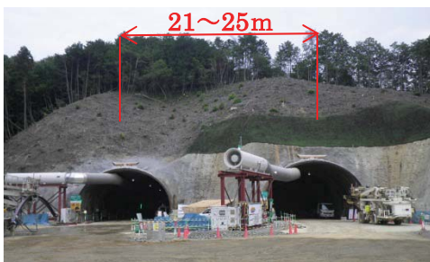
写真-1 終点側坑口全景
