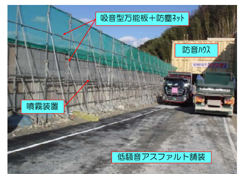
写真-2 起点側坑口 周辺環境対策
