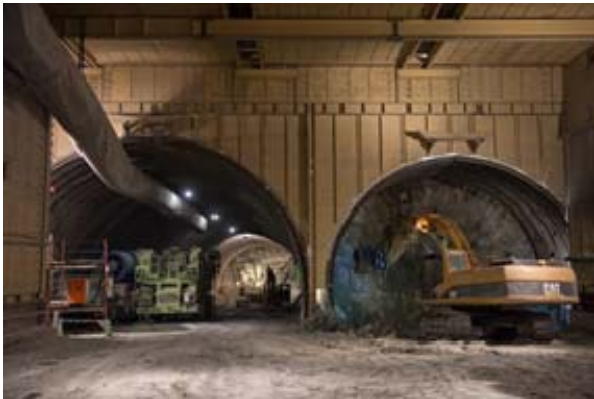
写真-1 トンネル上下線併進状況
