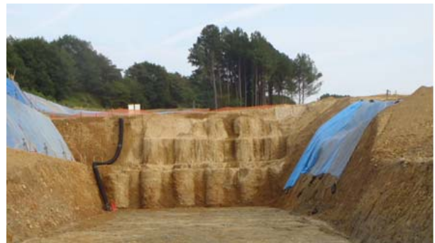
写真-2 RAS コラム改良境界掘削の状況
