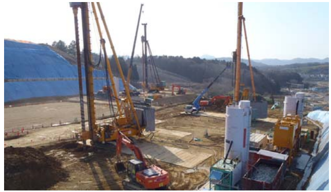
写真-1 RAS コラム工法の施工状況
