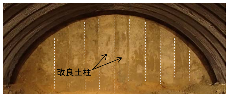
写真-4 人工地山の切羽状況（RAS コラム改良部）
