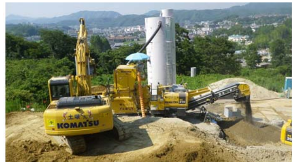
写真-3 自走式土質改良機による改良土の作成状況
