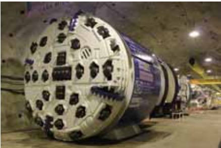
写真-1 TBM 全景
