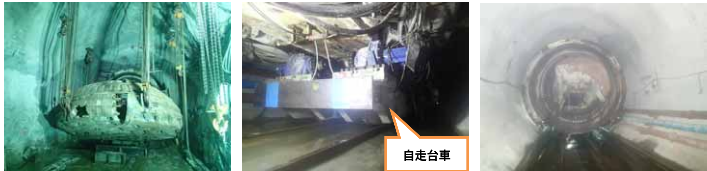
写真-2 TBM カッタヘッド解体状況 写真-3 自走式移動台車 写真-4 TBM 本体坑内自走搬出状況
