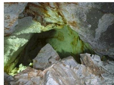
写真-1 天端部崩落状況
