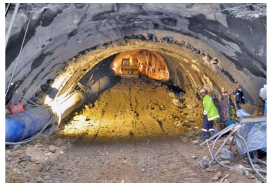
図4 掘削状況（上半後行坑掘削）
