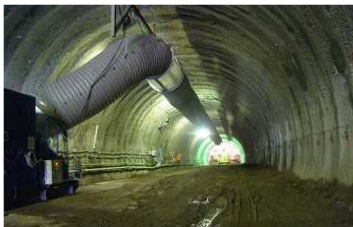
写-1 伸縮式ダクト坑内設置状況
