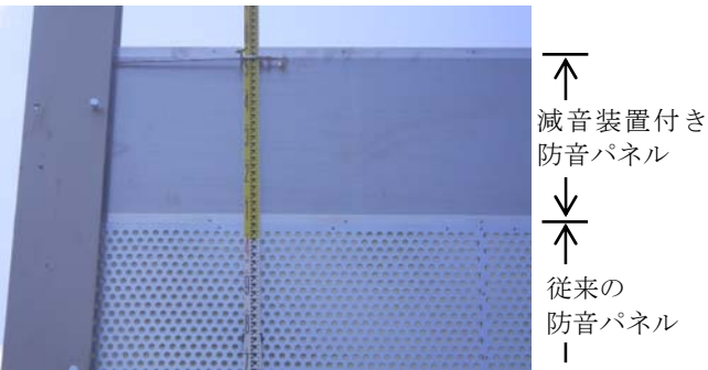
写真－1 減音装置付き防音パネル
