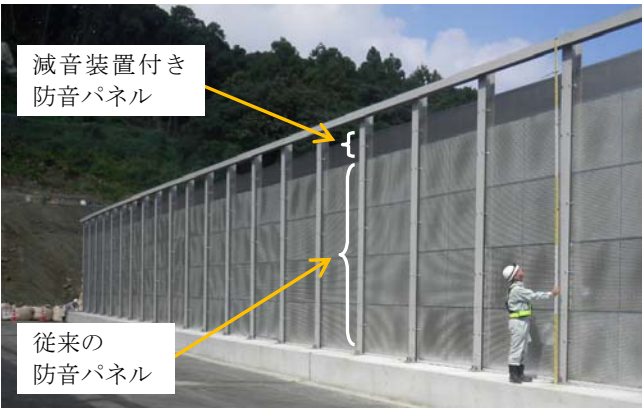
写真－2 減音装置付き防音パネル設置状況
