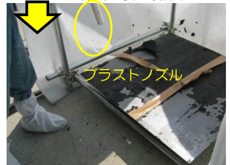
図3 ドライアイスブラスト工法による除去
