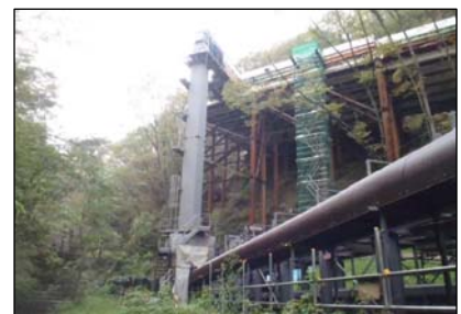
写真-1 堅シュート全景
