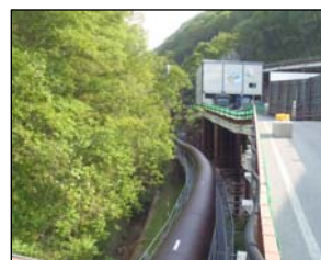
写真-5 定常時（カバー設置）
