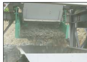
写真-3 フィーダー稼働状況
