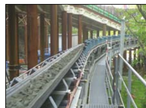
写真-4 搬出状況（試験）
