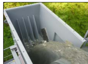
写真-2 ずり投入状況
