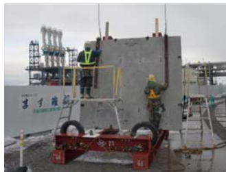
写真-1 プレキャスト型枠仮置き及び設置状況
