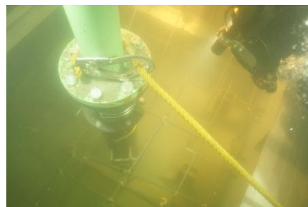
写真-2 コンクリートの打込み (水中写真)
