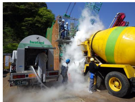
写真-1 液化窒素による プレクーリング
