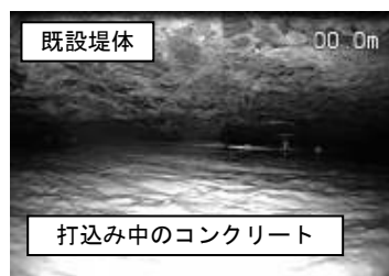
写真－1 CCDカメラによる 充填確認状況
