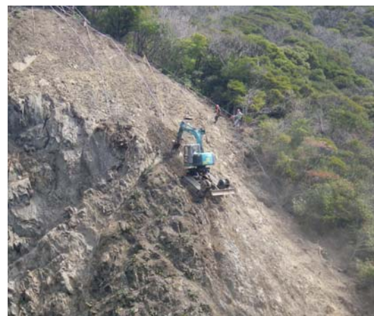
写真－2 掘削状況（RCM 工法）
