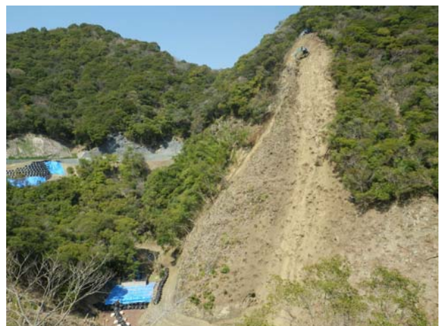
写真－1 左岸掘削全景
