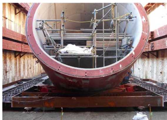
写真-2 開口補強施工状況
