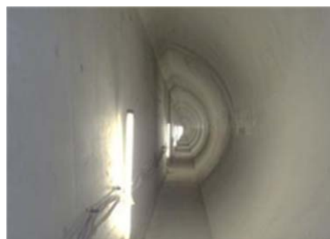
写真-2 二次覆工構築完了全景
