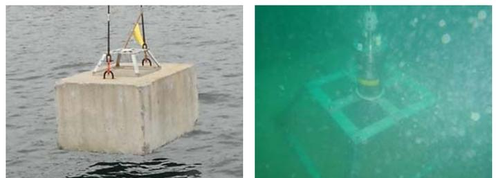
図-3 水圧式波高計設置状況
