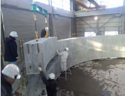
写真-5 組立状況
