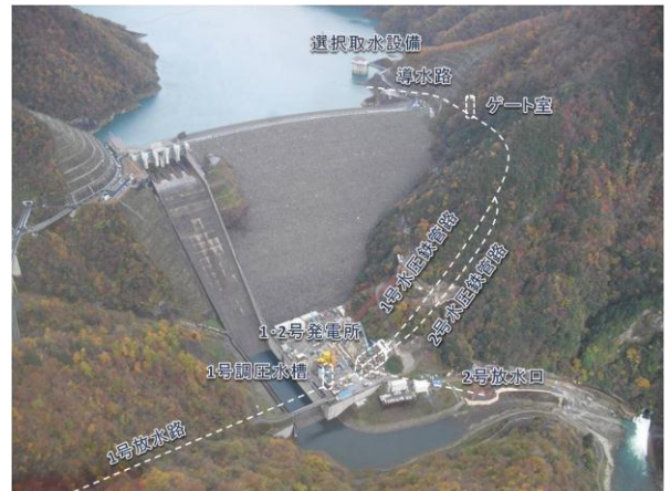
写真-1 徳山水力発電所全景
