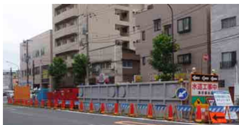
写真-2. 地上部常設作業帯
