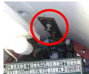
写真-4. 沈下防止緊結材
