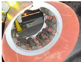
写真-3. 中押し装置
