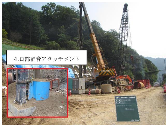
図-4 ダウンザホールハンマ工法施工状況
