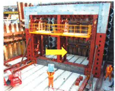
写真-2 函体刃口横移動
