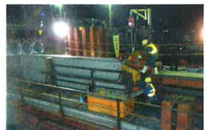
写真-1 縦2列施工状況
