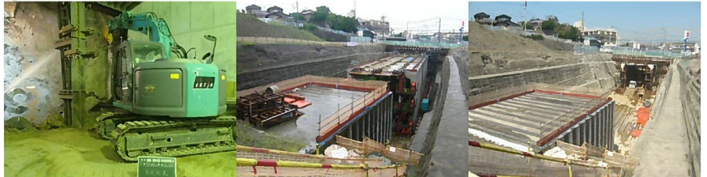
写真3 岩盤掘削施工サイクルおよび函体牽引前・完了写真
