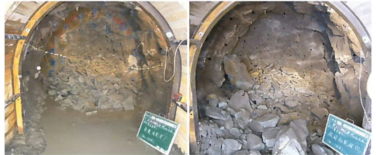
写真1 NRC 破碎前・破碎後
