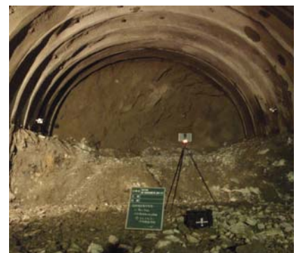
写真1 断面計測状況
