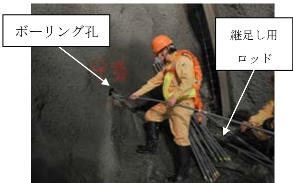
図2 簡易孔内カメラによる孔内観察実施状況の例
