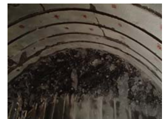
写真-1 交点部掘削状況
