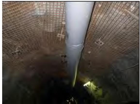
写真-1 ロックボルト + 溶接金網
