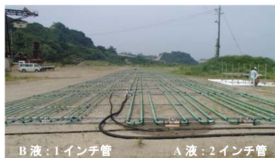
写真-1 圧送管敷設状況
