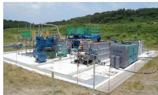
写真-2 プラント設置状況
