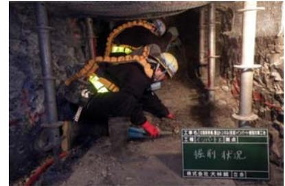
写真-1 横坑掘削状況
