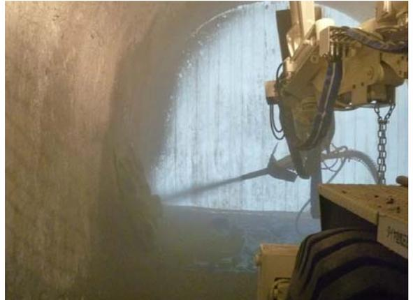
写真-1 吹付け試験状況 (配合 No.1)
